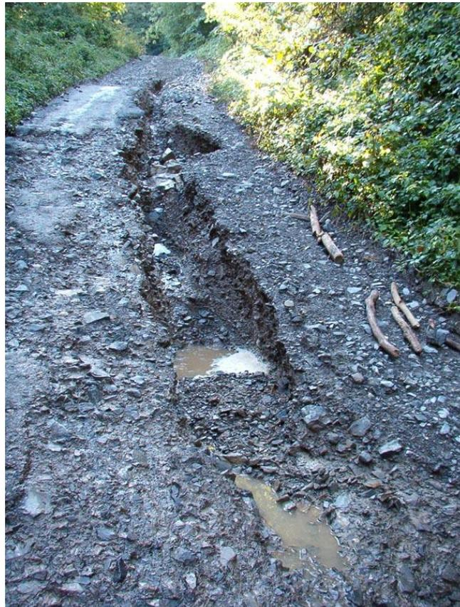
*Foto 33 - Fenomeni di erosione sulla strada di accesso al bacino C.na Cavo*
