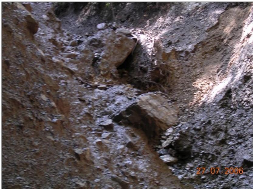
*Foto 17 – Particolare Asta Torrentizia del T. Granosa in approfondimento ed in erosione diffusa a monte dell'area del Camping*
