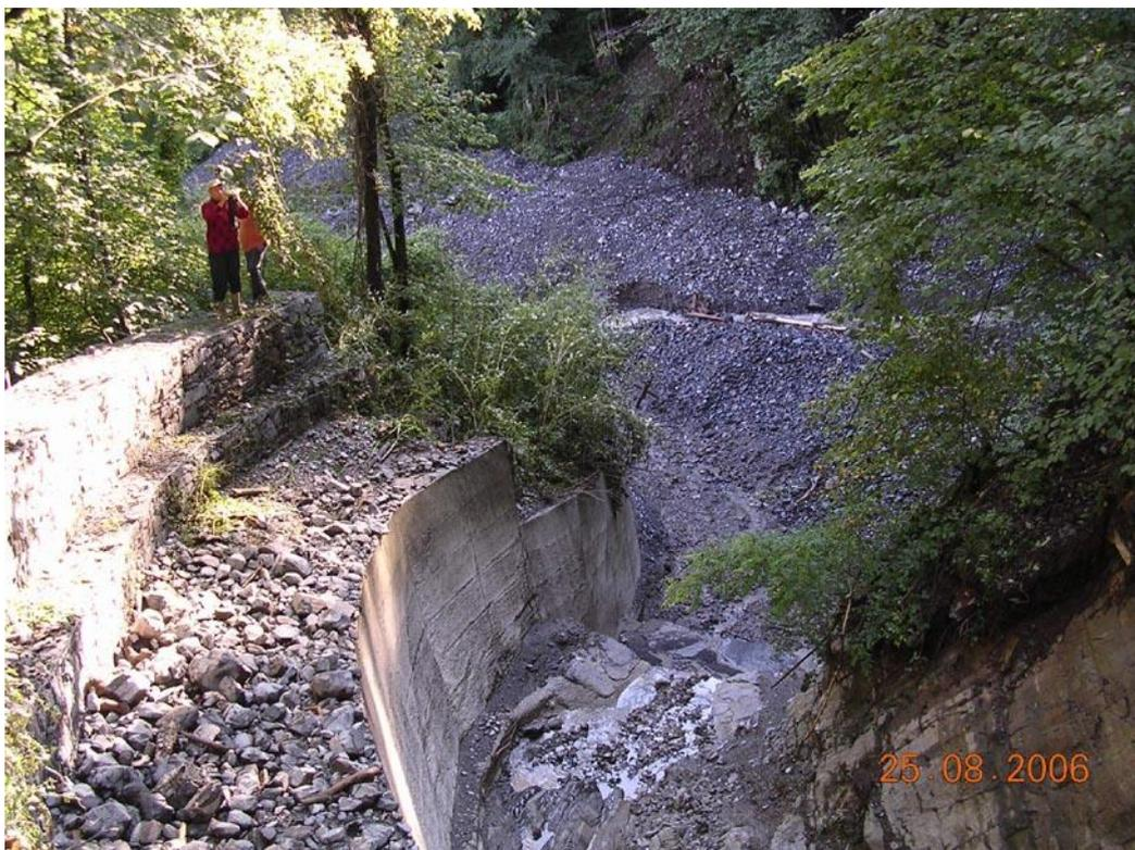
*Foto 31 - Erosione alla base del muro*
