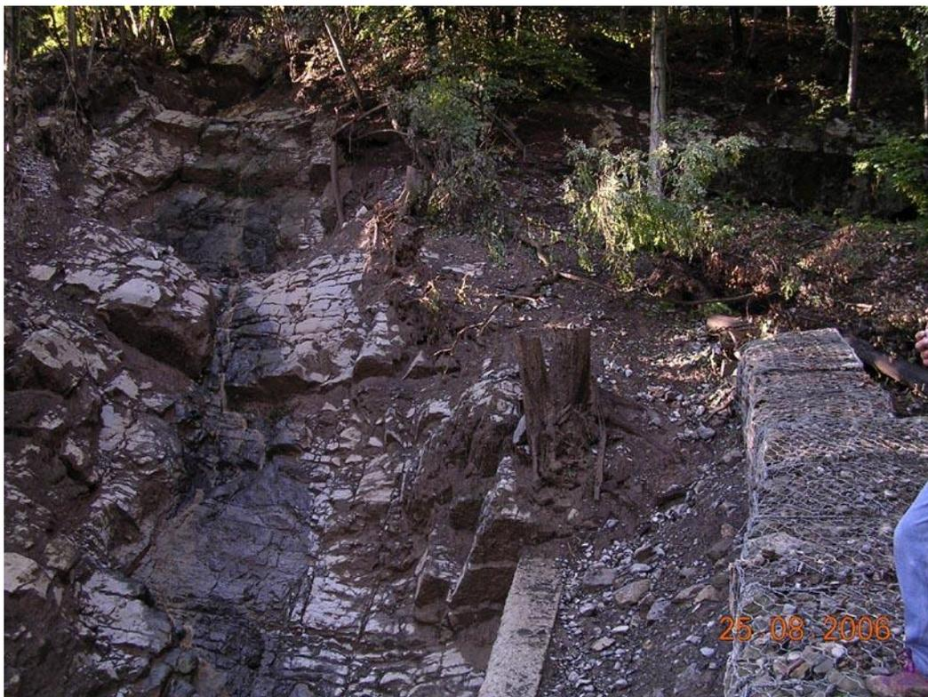
*Foto 30 - Salto a monte del muro e impatti di caduta della componente solida della colata*
