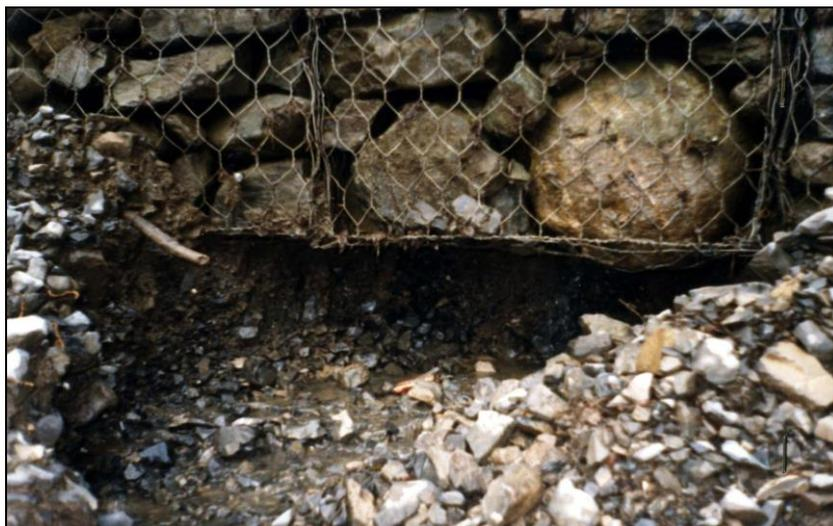
*Foto 6 – Particolare dello scalzamento alla base delle gabbionate*
