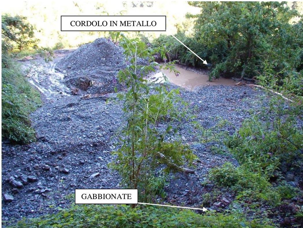
*Foto 32 - Bacino allo sbocco del T. C.na Cavo*
