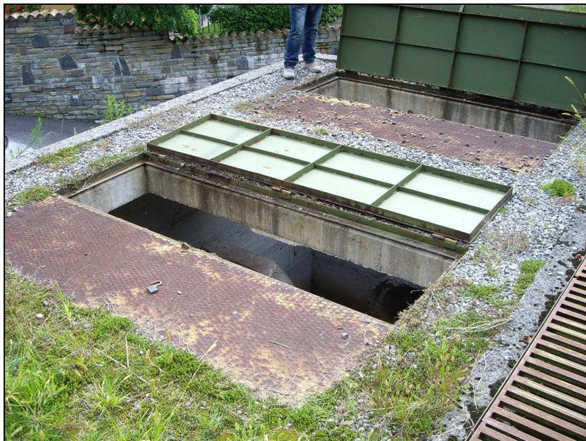
**FIG.46** Vasca di laminazione a quota 366 m.s.l
