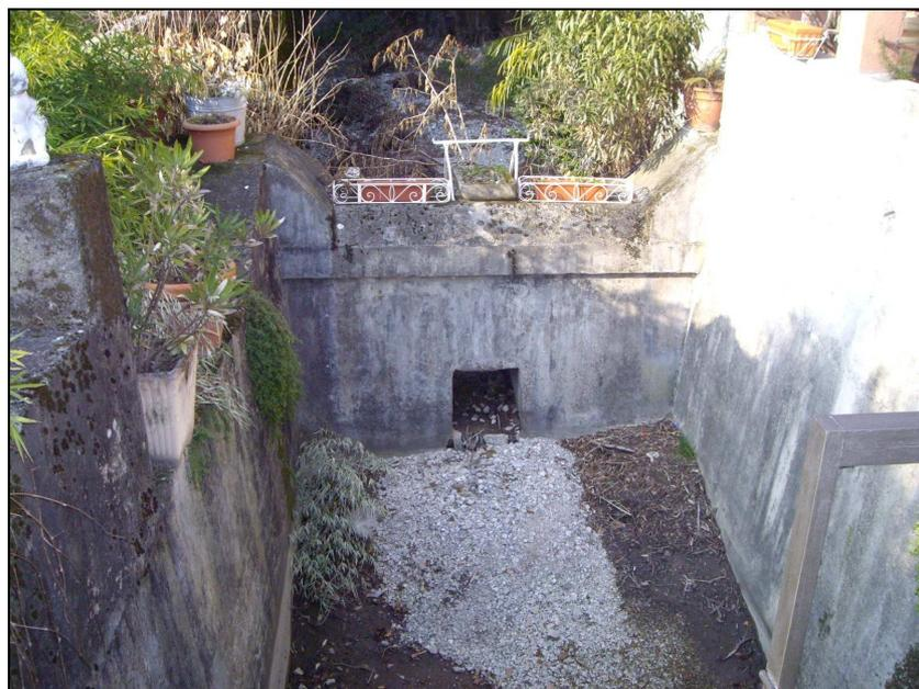
**FIG.30** Vasca di laminazione a quota 285.6 m.s.l
