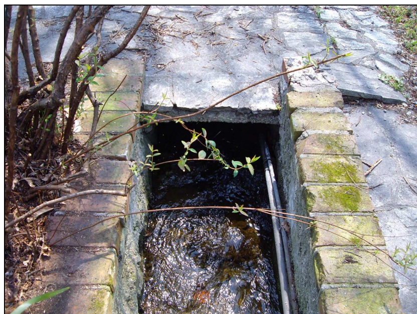
FIG.4 Tratto di corso d'acqua tombato
