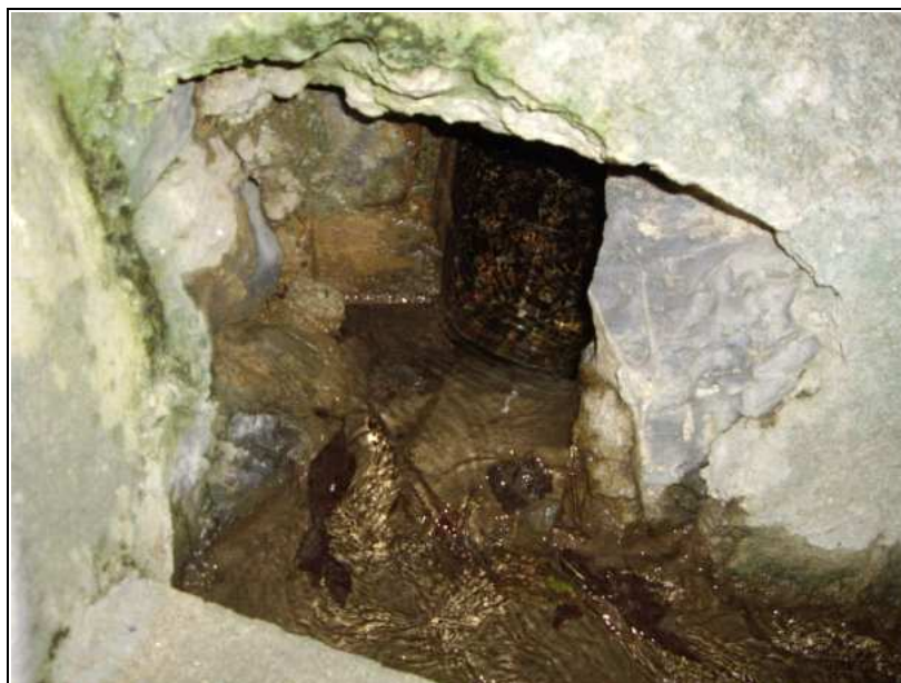
FIG.5 Tratto di corso d'acqua tombato
