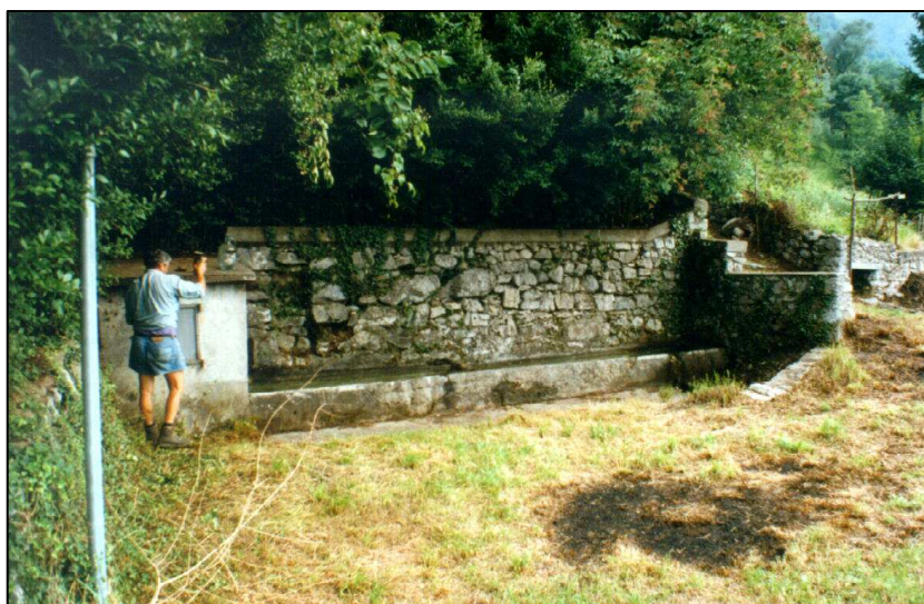
FIG. 3 Particolare sorgente captata con vasca di troppo pieno
