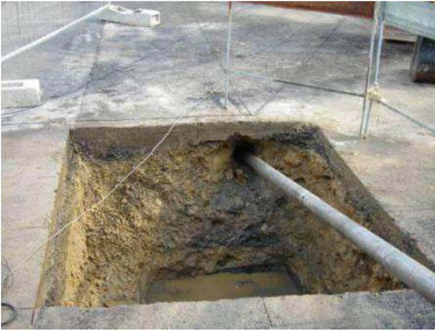
Interventi con tecnologie No - Dig (WEB)
