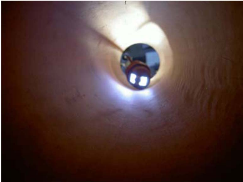
ingresso di una telecamera in una tubazione
