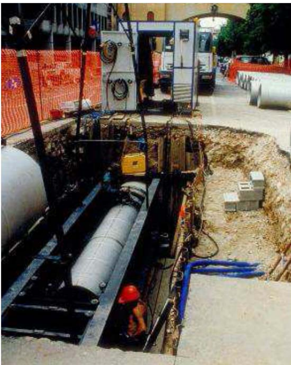
Interventi con tecnologie No - Dig (WEB)
