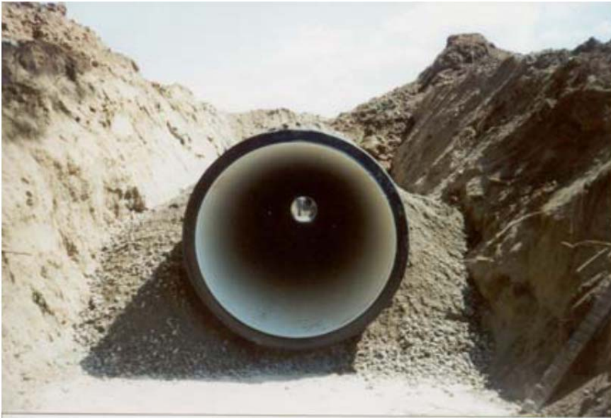
scavo in trincea con rinterro
