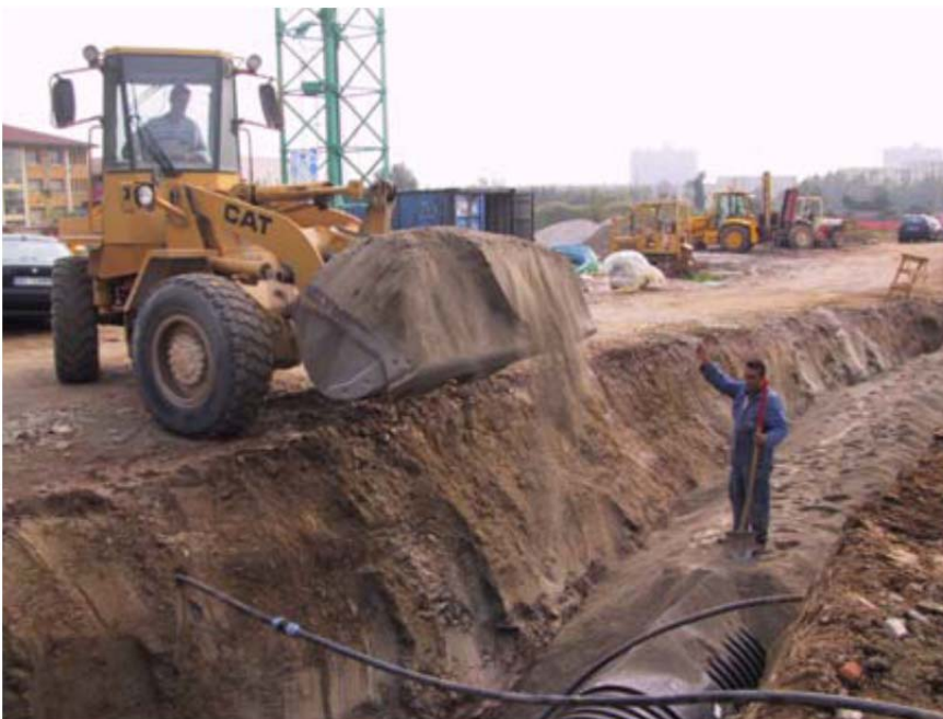
scavo in trincea con rinterro
