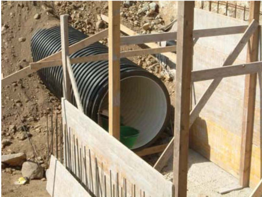
scavi in trincea con sostegno delle pareti
