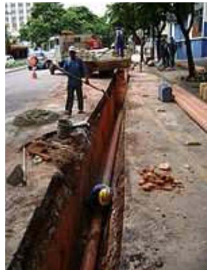
Immagini di posa in trincea
