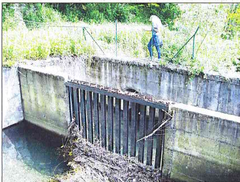
FIG. 2 Panoramica Vasca di laminazione in corrispondenza Corso D'acqua DD
